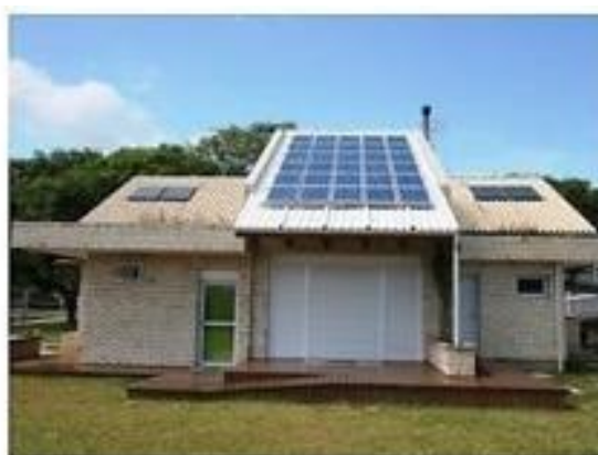
Figura 2: Sistema fotovoltaico concomitante
