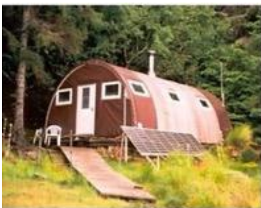
Figura 1: Sistema fotovoltaico autônomo
