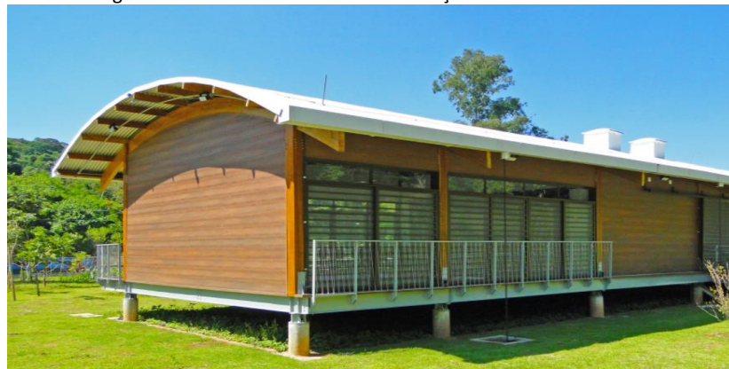
Figura 7: Estrutura metálica de sustentação da sede
