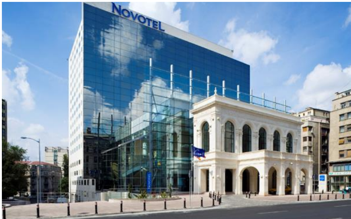
Figura 2: Prática da renovação fachadista através da “curetagem” em Bucharest, Romênia Fonte: https://commons.wikimedia.org/wiki/File:Novotel-bucharest-city.jpg Acesso em: 13/12/2020
