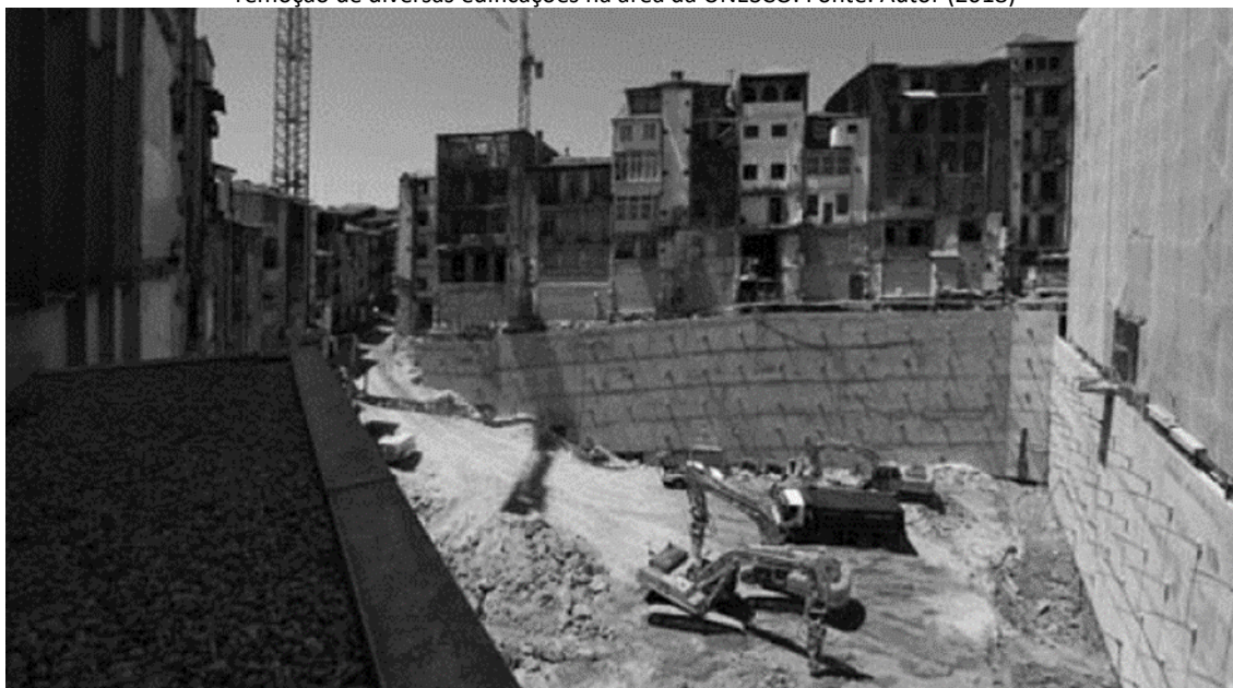
Figura 4: Quadra das Cardosas no Porto – durante a intervenção – construção de subsolo no miolo da quadra, após remoção de diversas edificações na área da UNESCO. Fonte: Autor (2018)
