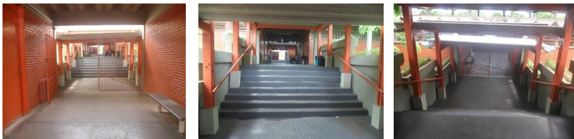
Escadarias para acesso ao pátio coberto, sem rampas.
