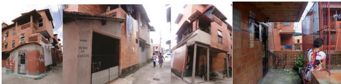
Figura 2: Modificações na fachada para adaptação de comércio e morador 1 no pátio de sua casa
