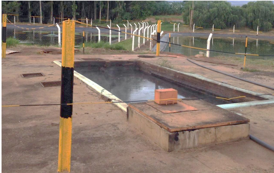
Figura 4 – Vista da estação de Tratamento
