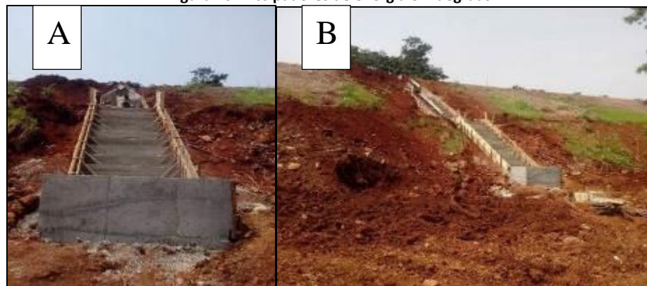
Figura 10: Dissipadores de energia em degraus
