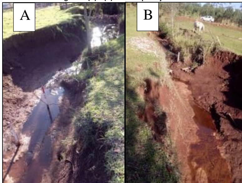
Figura 5: (A) e (B) Erosão tipo voçoroca em área rural
