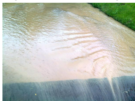
Figura 2: vertedouro da barragem
