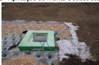
Figura 6 - Aplicação da manta e substrato vegetal
