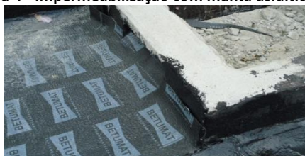
Figura 4 - Impermeabilização com manta asfáltica
