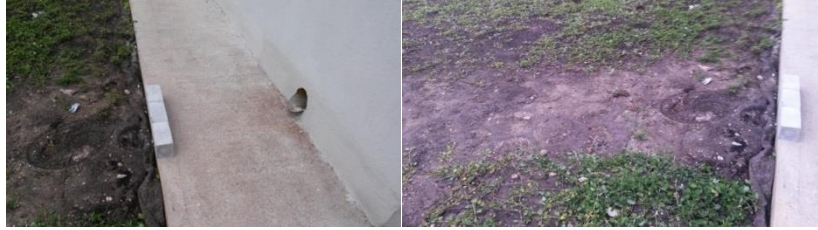
Figura 8 - Saída de água pluvial.
