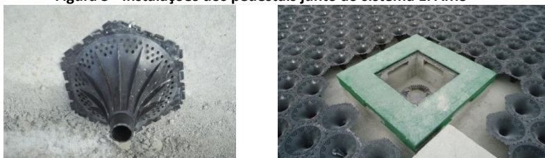
Figura 5 - Instalações dos pedestais junto ao sistema EPAMS
