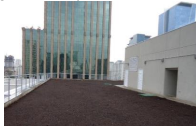
Figura 3 - Finalização da camada de substrato
