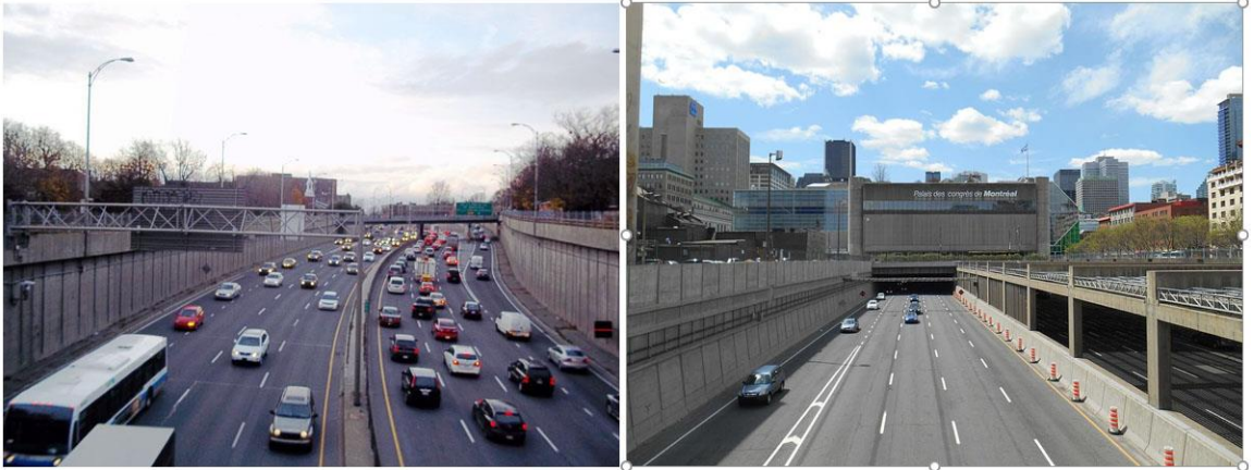
Figuras 8 e 9 - Ao trazer exemplos de implantações mal sucedidas, Jacobs cita as Autoroute de Montreal. Nas imagens, mostra-se a Autoroute 15 (à esquerda) e a Autoroute Ville-Marie (à direita).
