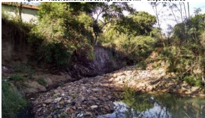
Figura 9 – Assoreamento no córrego Afonso XIII – braço esquerdo
