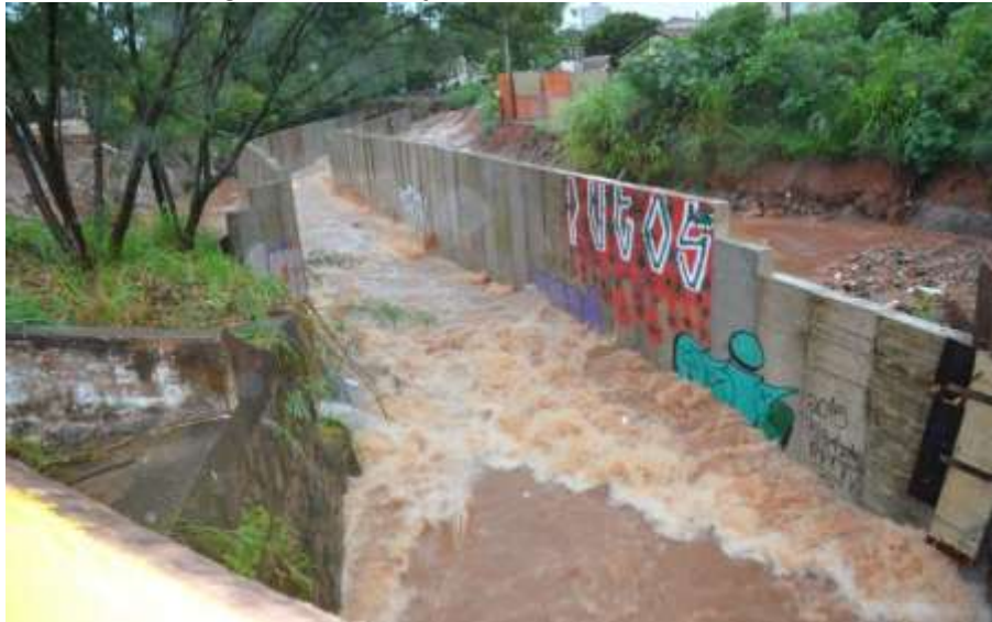
Figura 13 – Canalização vista da Rua Manoel F. Damião
