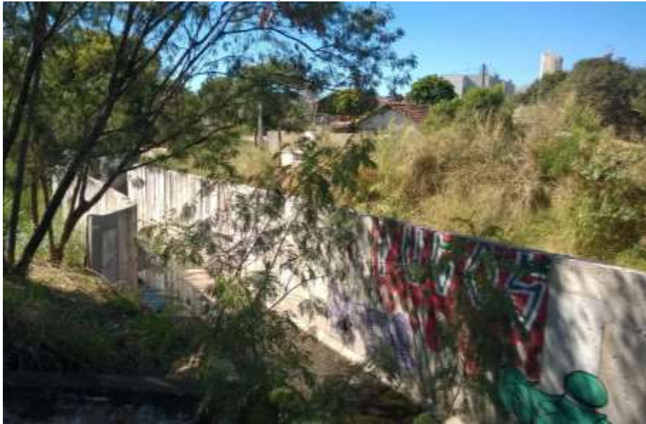
Figura 11 – Canalização vista da Rua Manoel F. Damião
