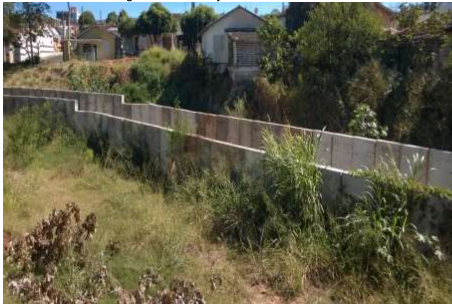
Figura 12 – Canalização vista da Rua Ana Dias
