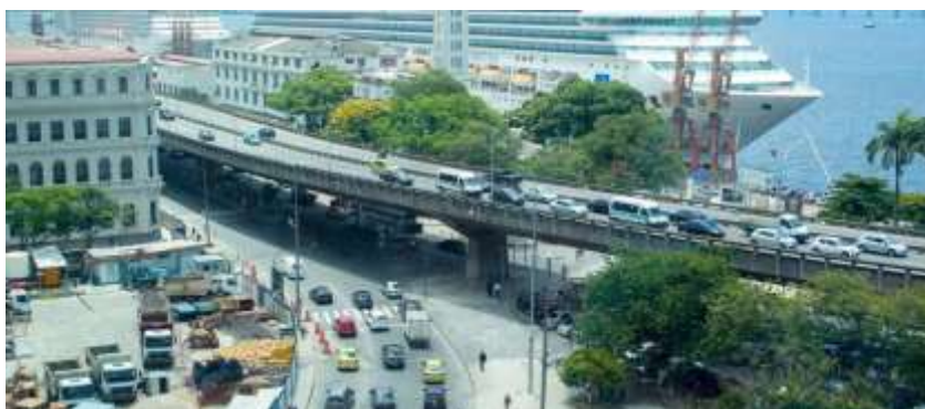
Figura 2: Elevado da Perimetral: degradação através das décadas.
