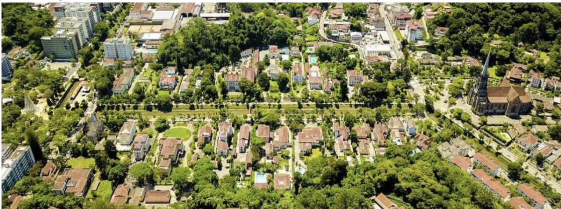
Figura 1 - Vista aérea da Av. Köeler, com a Praça da Liberdade à esquerda e a Catedral à direita.
