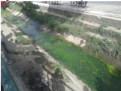
Figura 4 – Canal Avenida Ary Parreiras
